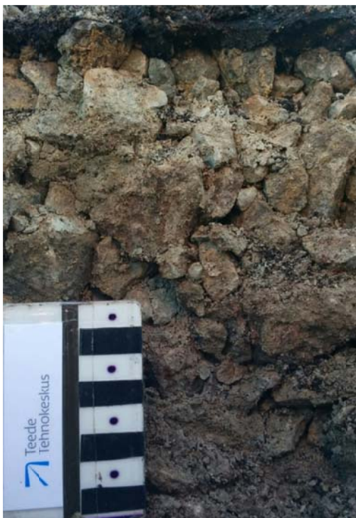
Foto 14. Vasakul fotol näha killustikukiht 17 cm, paremal bituumenliiv 5 cm
