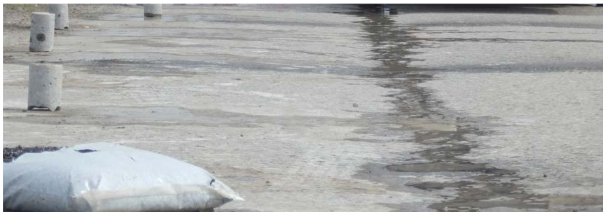
Foto 4. Roobas uuringulõigul
