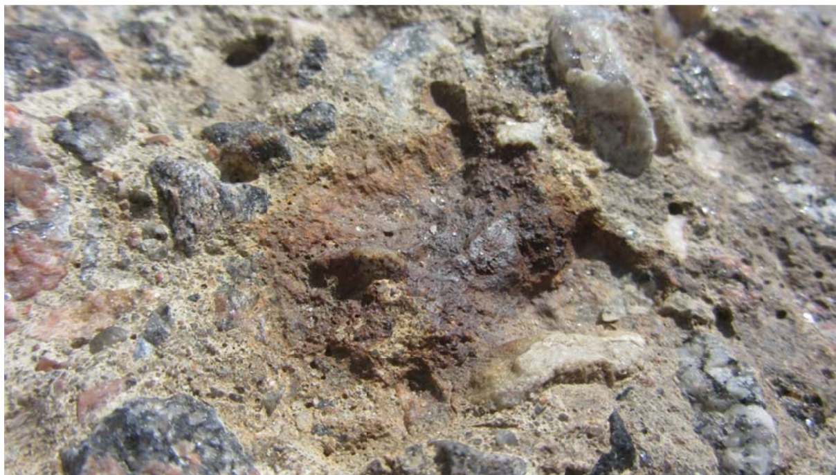
Foto 12. Korrodeerunud armatuur.
