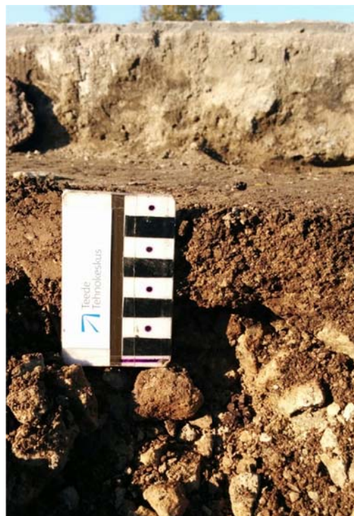
Foto 14. Vasakul fotol näha killustikukiht 17 cm, paremal bituumenliiv 5 cm
