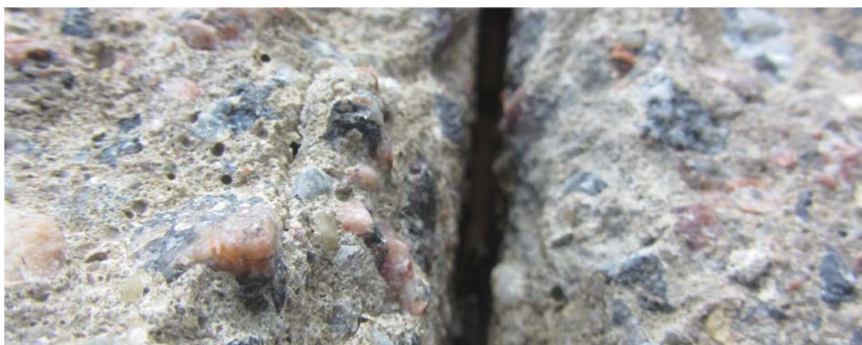
Foto 11. Halvasti säilinud vuuk. Killustik vähesel määral ümardunud ja segu mureneb
