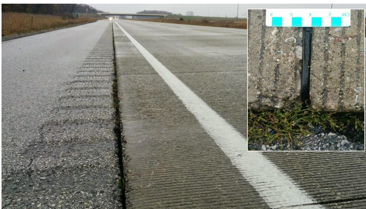
Foto 4. Betoontee maanteel 402, teepeenar asfaldist
